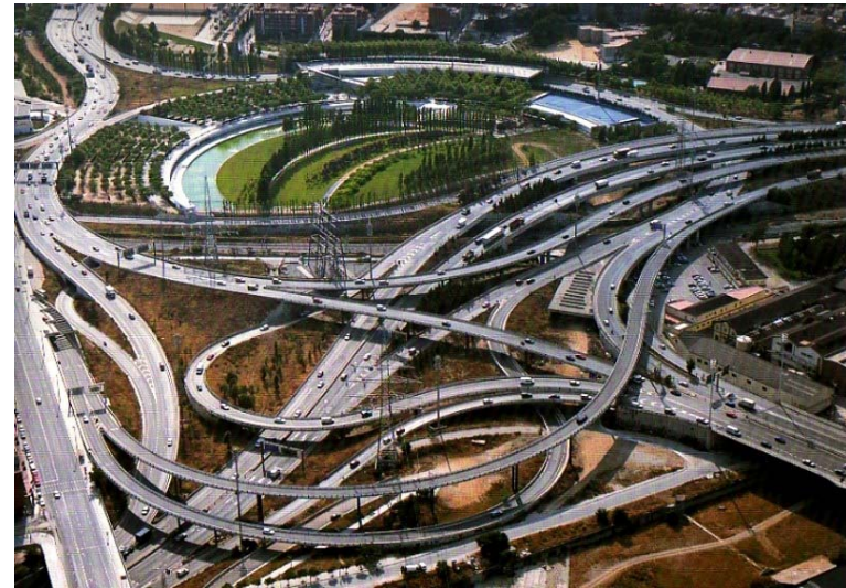
Autovía, nudo Trinidad (Barcelona)
