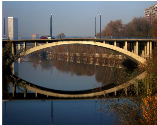
Puente del Cubo (Valladolid)
