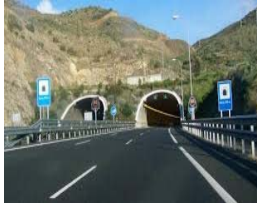
Túnel de Guadarrama
